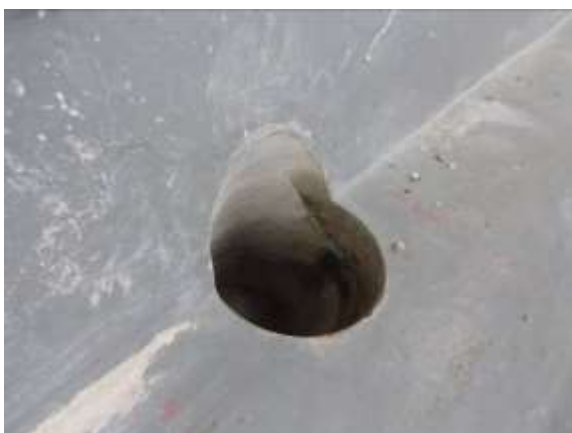
Afbeelding 4.5: Kernboring in aansluiting galerijplaat met gevel. Geen scheurvorming.
