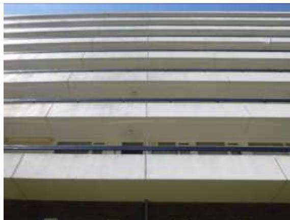
Afbeelding 4.2: Betonnen borstweringen met metalen leuning.
