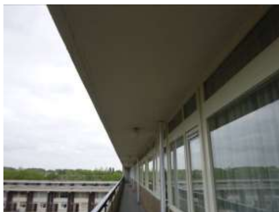
Afbeelding 4.6: Onderzijde galerijplaten geschilderd.
