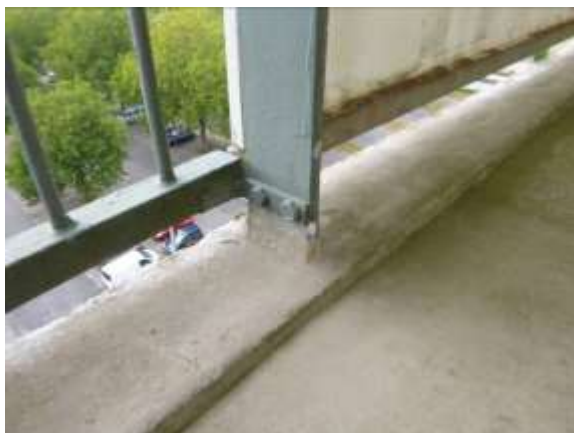
Afbeelding 4.11: Aansluiting stalen balustrade met dikkant balkonplaat.
