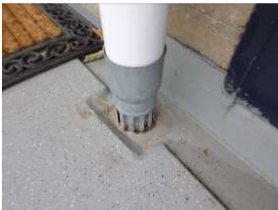
Afbeelding 4.3: Afschot loopt richting gevel. Gootje langs gevel gecreëerd.
