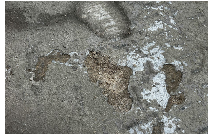
Foto 18 – Technisch Onderzoek – Slijtage/ aantasting van de toplaag van de zandcementafschotlaag door het ontbreken van een gedegen waterafdichting..
