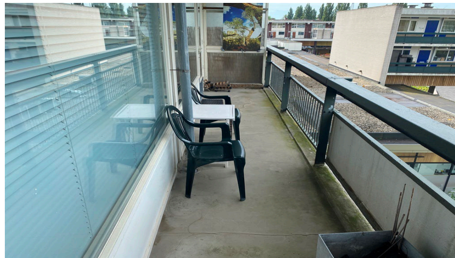
Foto 1 - Balkons gesitueerd op de 2e t/m 9e verdieping.
